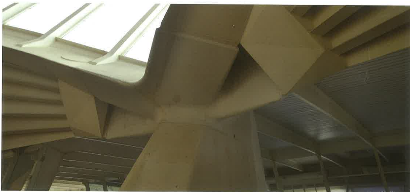
Een voorbeeld van een goed 'huwelijk': hier gaan staal en beton naadloos in elkaar over.
